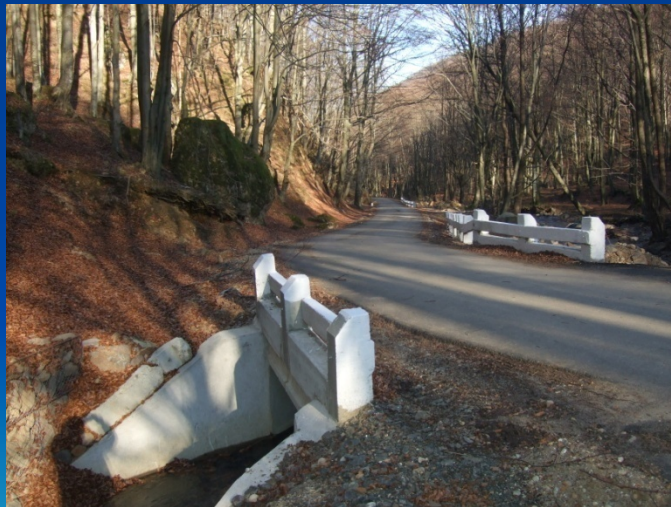
Drumul modernizat Vama – Băile Puturoasa
